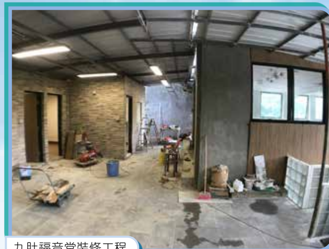
九肚福音堂裝修工程
